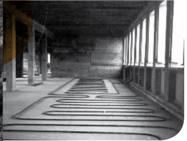
Bâtiment administratif du Costic (dalle pleine) en 1960
