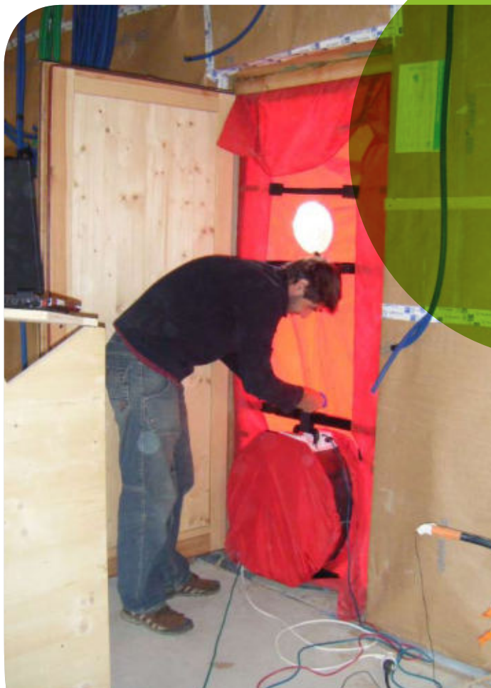
Tests de perméabilité à l'air du bâtiment
